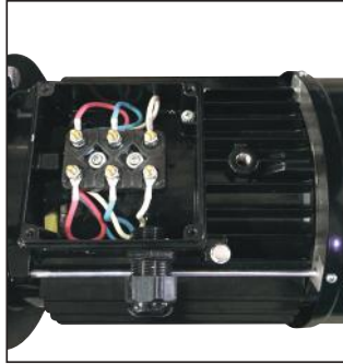
Şekil 2. Yıldız-Üçgen Bağlantı Fig.2. Star-Triangle Connection
