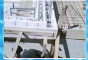
Üstten Taşmalı Stropor Tuğla Köşe Detayı 3
