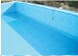
Üstten Taşmalı Havuzun Membran Montajı sonrası İç Görünümü
