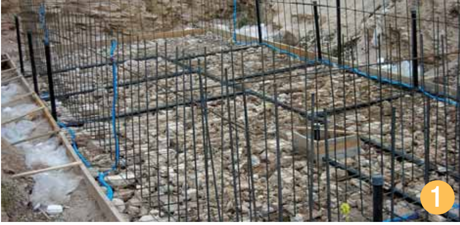
Stropool RECTON-TM zemin demir döşemesi
