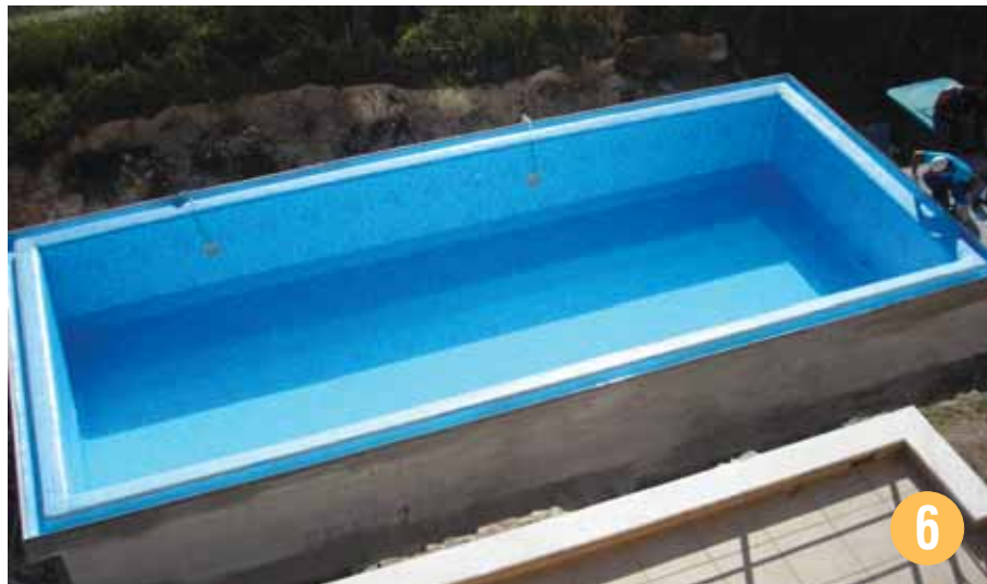
Stropool RECTON-TM Membran kaplama işlemi tamamlanmış, Taşma Kanalları Poliüretanla izole edilmiş ve kısmen doldurulmuş havuz.
