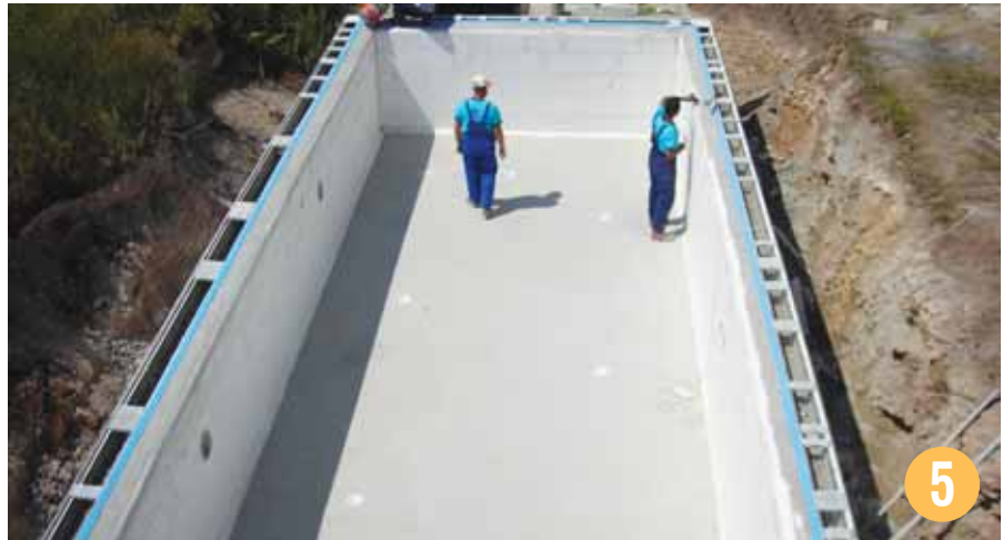
Stropool RECTON-TM Taşma Bordür Sıvası tamamlanmış, Membran Tespit Çıtası sabitlenmiş ve Membran kaplamaya hazır havuz.
